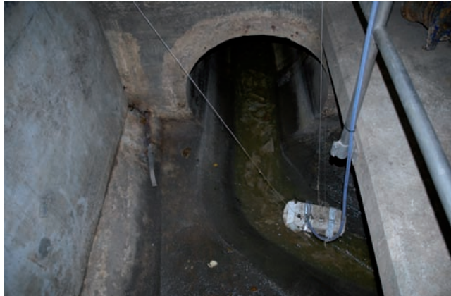
Probenahme in einem Entlastungsbauwerk
