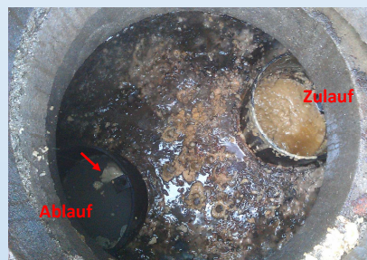
Abb. 1: Schlecht gewarteter Fettscheider mit Fettpartikeln im Ablauf.
