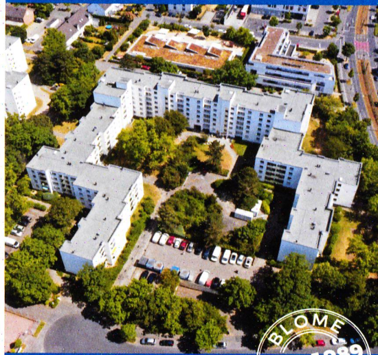
Bonn: Sanierungsprojekt mit 300 Wohneinheiten
