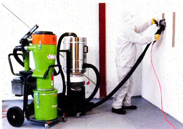
Sicherheit ist beim Sanieren asbesthaltiger Wände das A und O. Die NHW hat eine Methode entwickelt, Wände emissionsarm zu behandeln.
