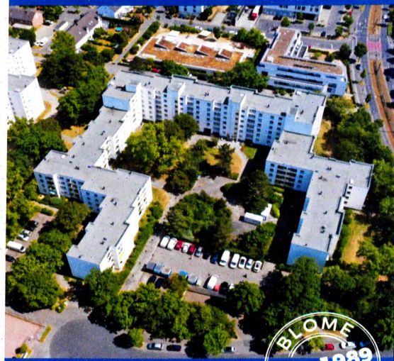
Bonn: Sanierungsprojekt mit 300 Wohneinheiten
