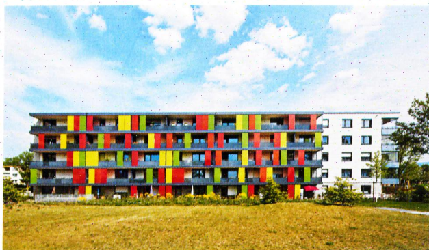
Technisch hochwertiger Lärmschutz für Anwohner kann ein Quartier gestalterisch auch aufwerten
