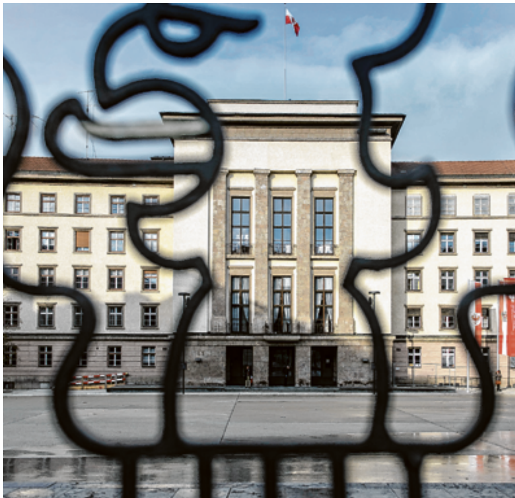
Einst Gauhaus, jetzt Neues Landhaus: Der Bau wurde in den letzten Monaten umfassend saniert.
