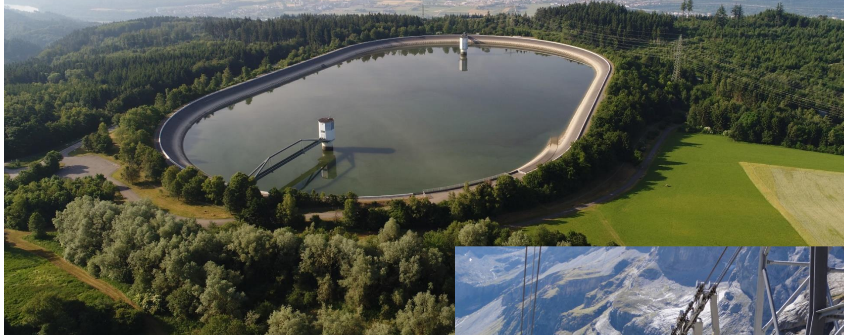
Eggbergbecken mit Stauzielerhöhung, KW Säckinggen, Deutschland
