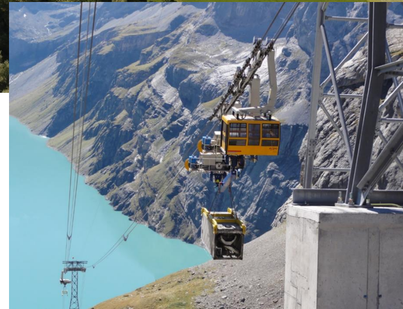
Bauseilbahn Erstellung KW Limmern, Schweiz
