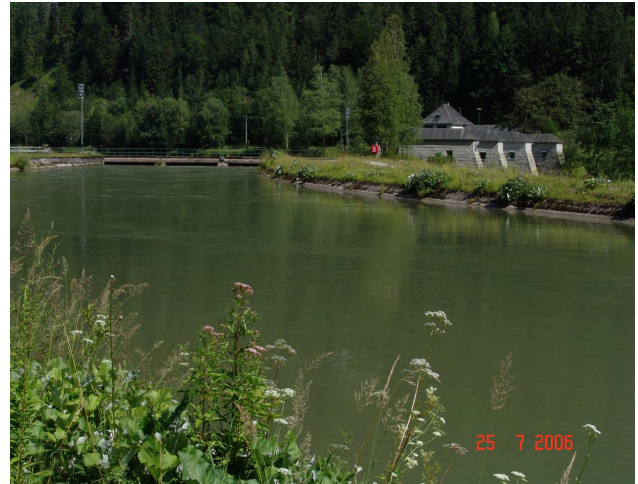
Abbildung 2: Oberwasserkanal und Wehranlage
