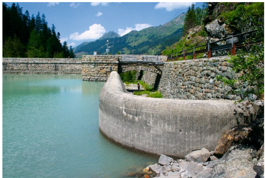
Bild 1: Foto der Hochwasserentlastungsanlage Ausgleichsbecken Enzingerboden – vor der Umbaumaßnahme
