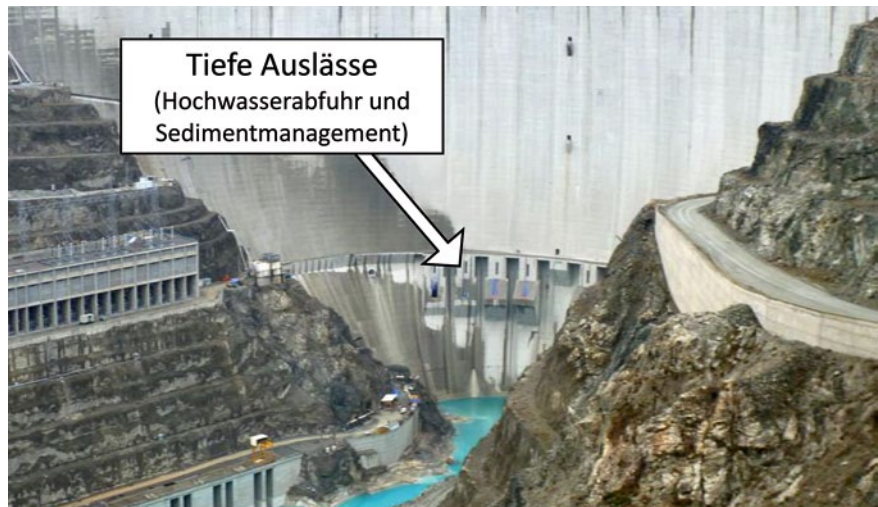
Bild 5: Tief angeordnete Auslässe am Deriner-Damm im Nordosten der Türkei
