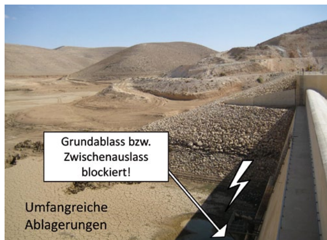
Bild 2: Verlandeter Stauraum im Mittleren Osten
