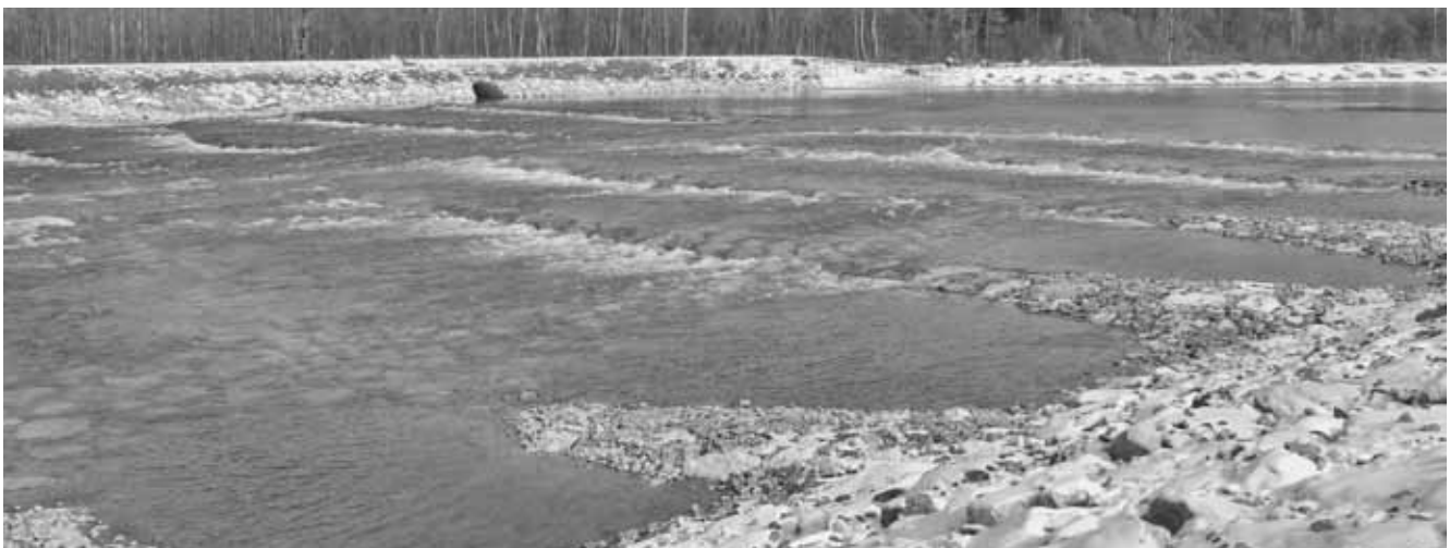
Bild 2: Aufgelöste Sohlenrampe an der Unteren Salzach bei Flusskilometer 51,9
