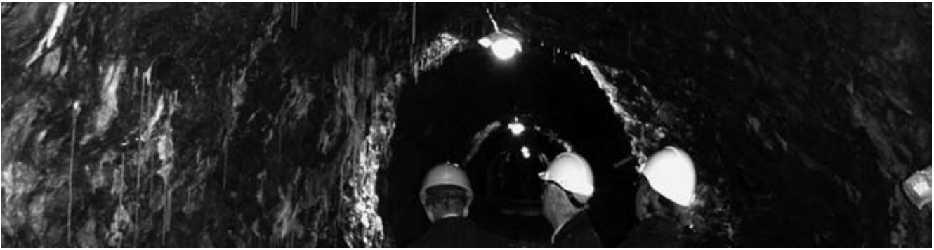
Bild 2: Inspektion eines Kontrollganges im Felsuntergrund luftseitig des Dichtungsschirms (Schweden, 2008)
