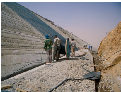
Bild 3: Merowe Dam, Sudan: Installation des faseroptischen Kabels
