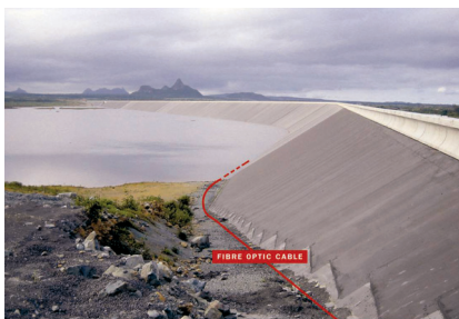
Bild 2: Midlands Dam, Mauritius: Verlauf des faseroptischen Leckortungskabels
