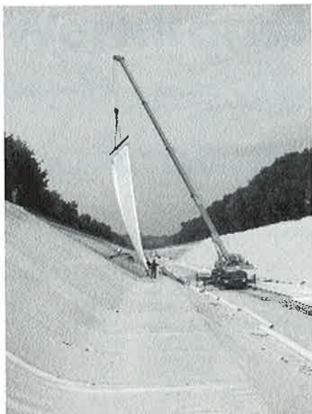
Bild 3: Vollausskleidung des Kanalprofils mit der PVC-Folie „Sibelion CNT“
