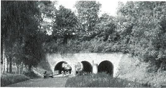
Bild 1: Das Strogenbauwerk (Überführung des mittleren Isarkanals)
