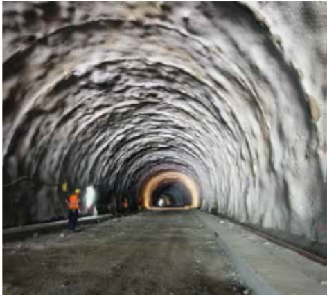
Abb. 3: Blick in einen Straßentunnel
