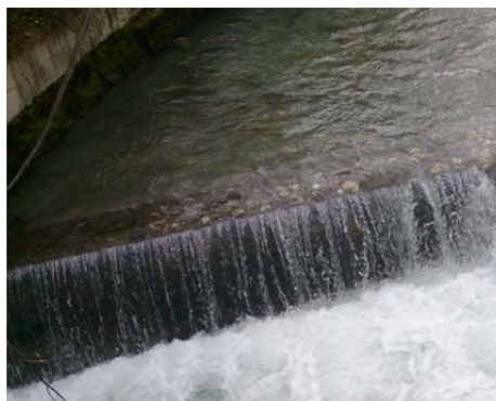
Abbildung 11 und 12: terrestrische versus ALS-Punkte im Bereich der überströmten Rampe
