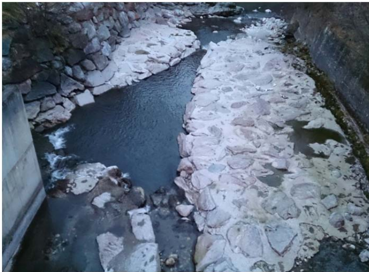
Abbildung 4: die Sill bei Mühlbachl im „trockenen“ Zustand
