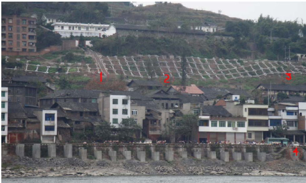
Abb. 1: Monitoring einer Hangbewegung über faseroptische Sensoren in China
