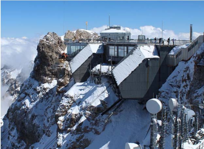
Nordseite – Ansicht von Westen
