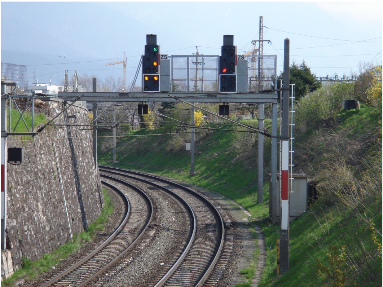
Messstrecke Konzertkurve – Gleis 604 links – Gleis 603 rechts, FR Ibk.Wbf. – Ibk.Hbf.
