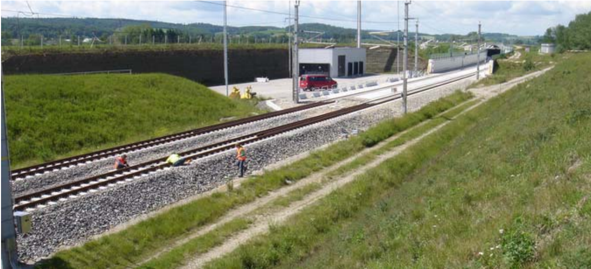
Neubaustrecke Wien – St.Pölten – Übergang Feste-Fahrbahn - Schotteroberbau
