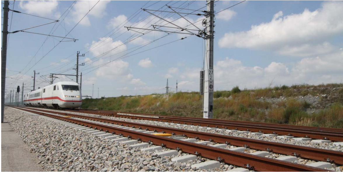
Neubaustrecke Wien – St.Pölten – Messzug
