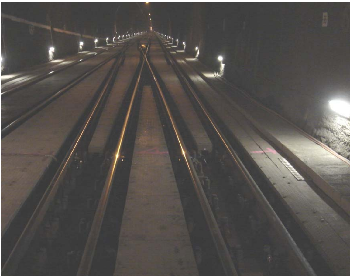
Nr. 56 Arlbergtunnel – Blickrichtung nach St. Anton
