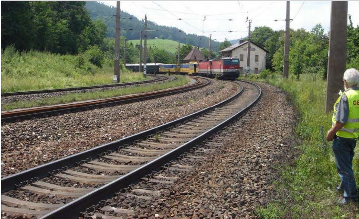
Messbogen Semmering - Eichberg km 88
