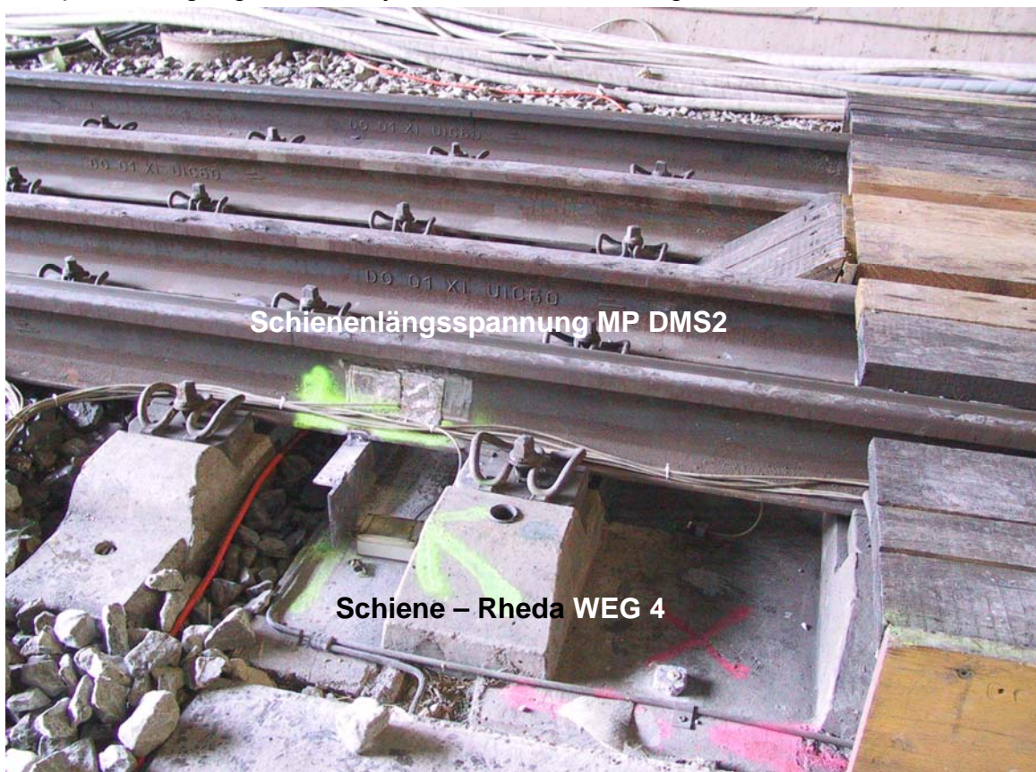
Beispiel: Übergang Oberbausystem Rheda - verfestigtes Schotterbett
