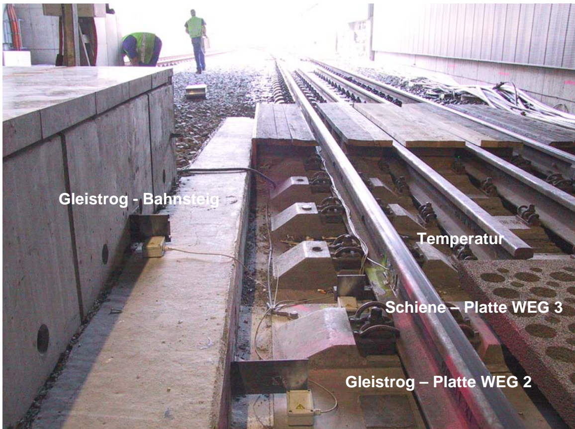
Beispiel: MFS - Feste Fahrbahn – System ÖBB - Porr
