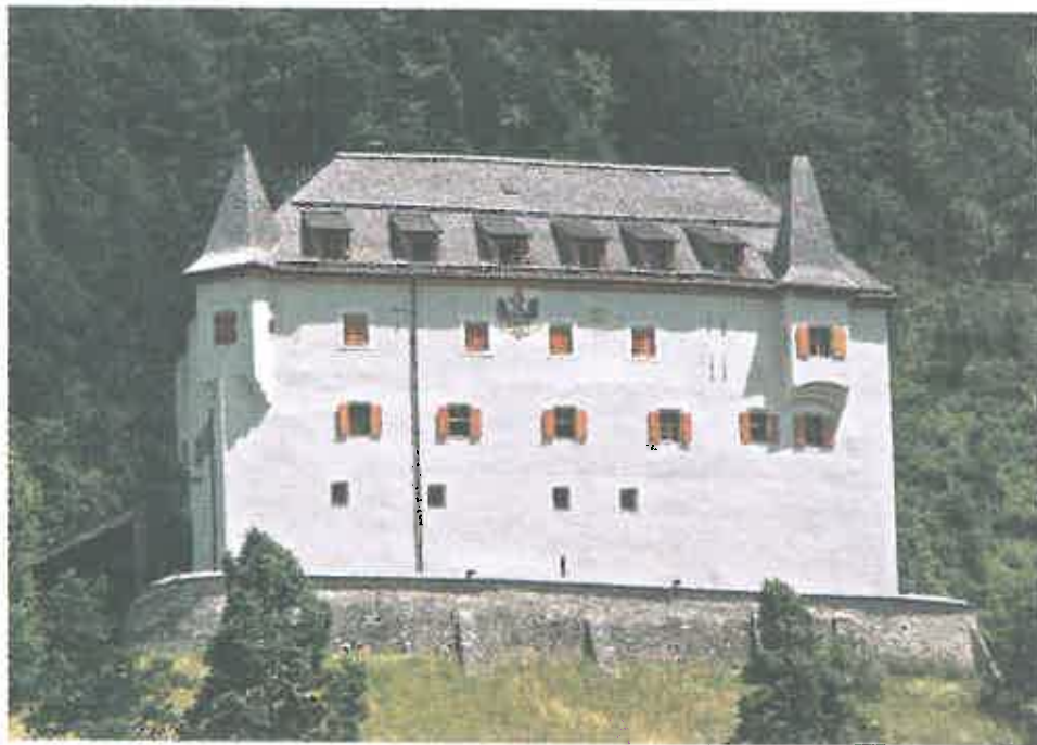
Entpuppte sich im Zuge der Generalsanierung als „Schlaraffenland“ für Archäologen: Schloss Lengberg. Foto: Funder
