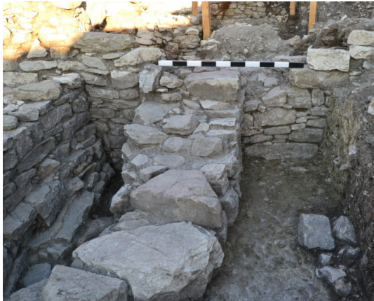
Türmchen-Technik der älterarchaischen Mauer (von O)
