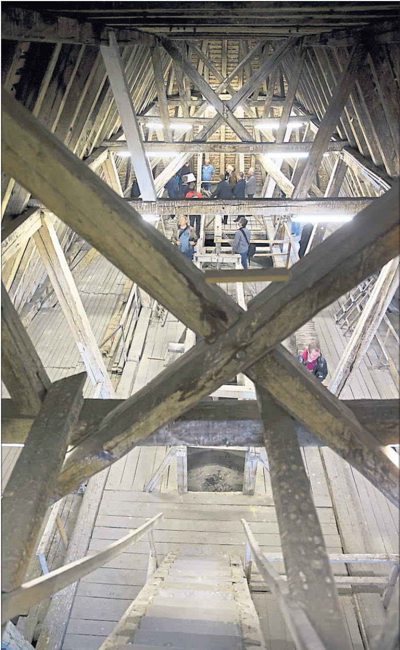
Die hölzerne Dachkonstruktion der Wiener Malteserkirche.
