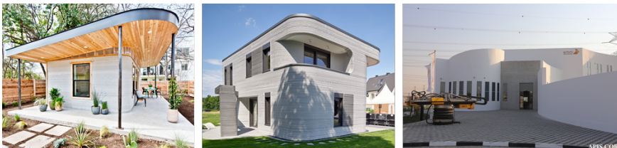
Abb. 4-1.: Erstellung eines Rohbaus mittels Extrusion-Verfahren unter Einbau von vorgefertigter Elemente wie bspw. Türen oder Fenster. Die zur additiven Fertigung eingesetzten System gehören zu:
