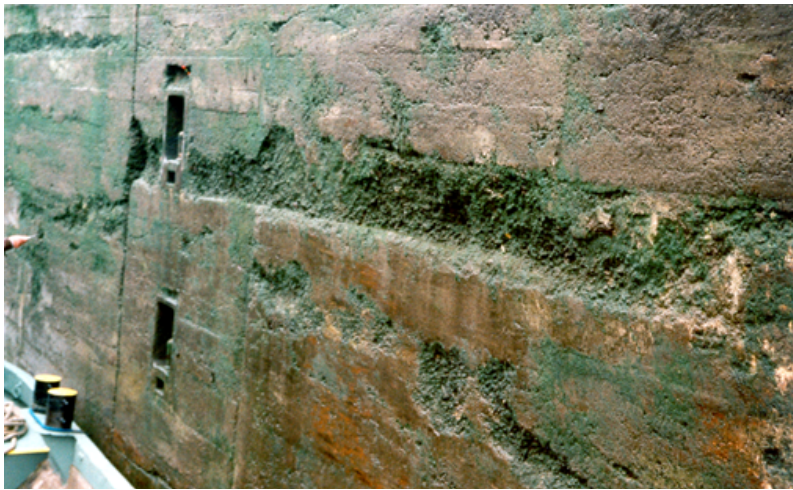
Abb. 2-1: Kammerwand in zonierter Bauweise mit Betonausbrüchen
