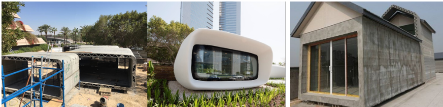
Abb. 4-3: Das weltweit erste 3D-gedruckte Bürogebäude „Office of the Future“ in Dubai (Mitte) [29]. Die äußere Tragstruktur wurde vorgefertigt (gedruckt) und vor Ort zusammengesetzt und ausgebaut (links) [30]. Auf der rechten Seite ist ebenfalls ein von der chinesischen Firma WinSun vorgefertigtes Gebäude [31].
