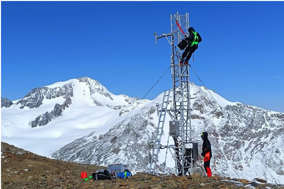
Abbildung 25: Wartungsarbeiten im Hinteren Eis. Foto: Rainer Prinz, 10.07.2025
