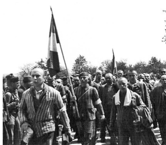
Baustelle Loibl Nord (ganz li), ehemalige Häftlinge vor dem Nordportal des Loibltunnels im Mai 1945 (Mitte), Häftlinge nach der Befreiung (re)
