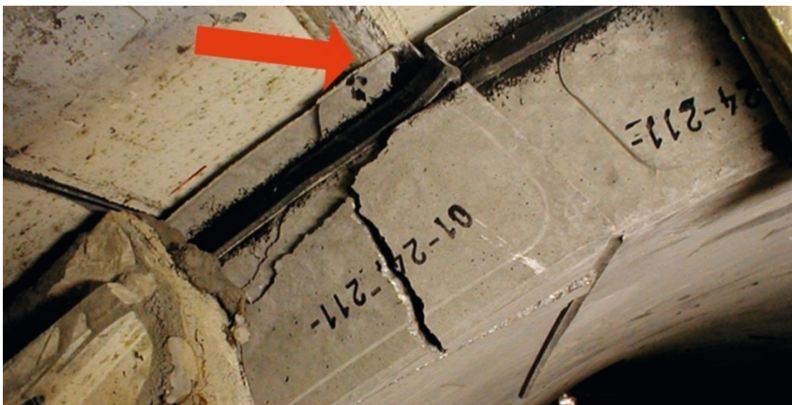
Abbildung 2-27: Abplatzung aufgrund Schildschwanzkontakt [8]
