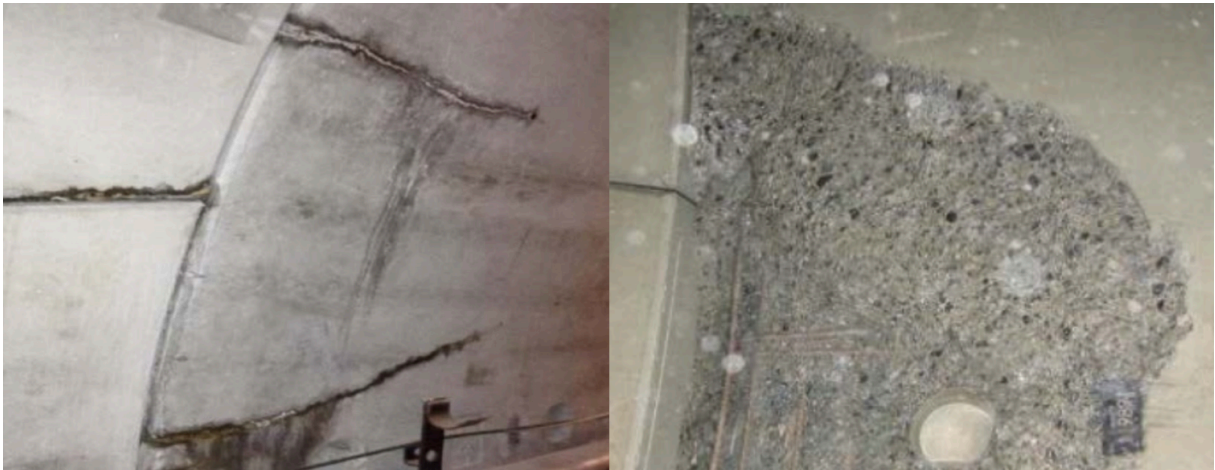
Abbildung 2-22: Links: Risse; Rechts: Abplatzung [9,48]
