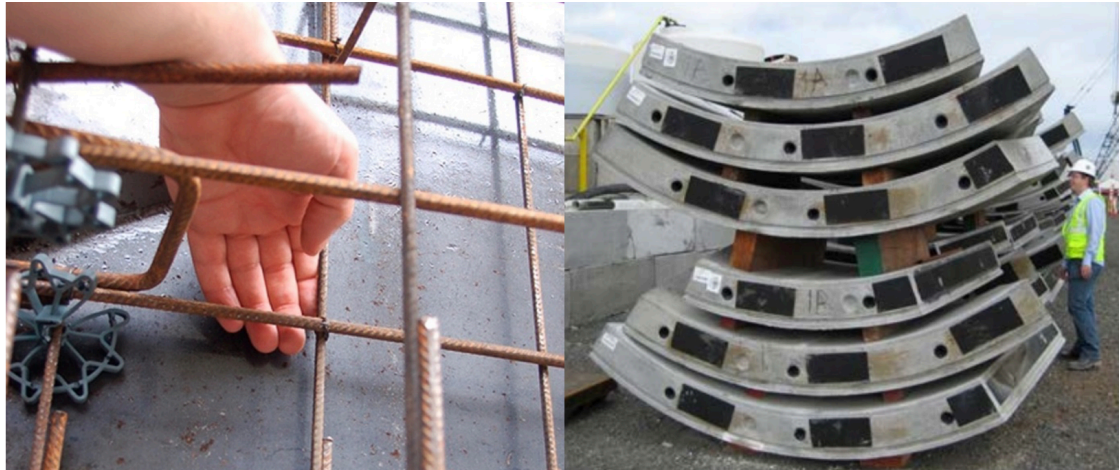
Abbildung 2-25: Links: Umgeknickter Abstandshalter [8] Rechts: Schlechte Positionierung der Zwischenleisten [50]
