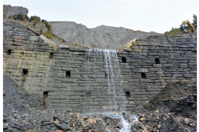
Bild 6. 23,5m hohe Konsolidierungssperre Abb.: Hofmann (2016) Fig. 6. Torrential barrier of 23,5m height Source: Hofmann (2016)
