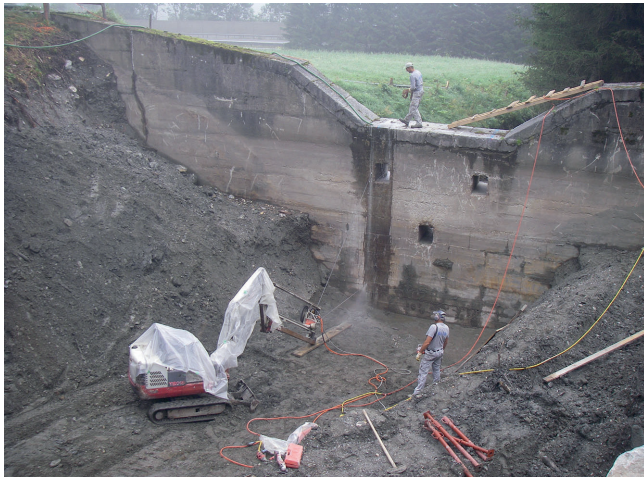
Bild 8. Freigelegte Konsolidierungssperre mit Dolen Abb.: Markus Moser (2018), Wildbach- und Lawinenverbauung, GBL Lungau Fig. 8. Uncovered torrential barrier with outlets Source: Markus Moser (2018), Wildbach- und Lawinenverbauung, GBL Lungau
