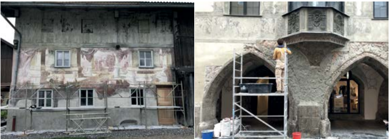
In Kooperation mit RestauratorInnen und der Baustoffindustrie: Entwicklung eines Baukastensystems für Putz und Mauermörtel auf Basis natürlicher hydraulischer Kalke. Anwendung an prominenten Objekten in Tirol (links: Sockelputz Köpflehaus in Höfen, rechts: Kompressenputz und Neuverputz Trautsonhaus in der Innsbrucker Altstadt.)
