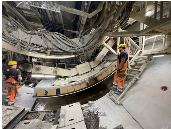
Abbildung 21: Grobjustierung der Tübbingsegmente für den lagerichtigen Einbau
