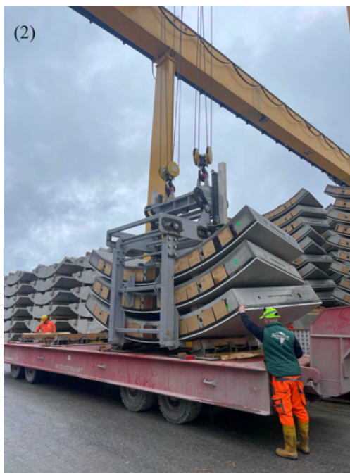
Abbildung 14: Verladung der Tübbinge mit dem Portalkran (1) auf das Transportfahrzeug (2)
