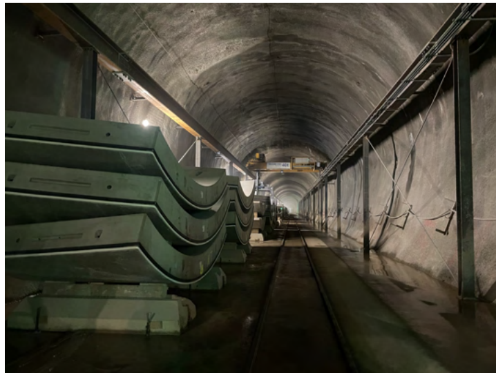
Abbildung 16: Lagerfläche der Tübbinge im Logistikbereich der NHS Innsbruck
