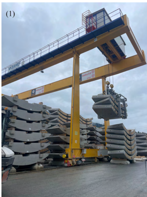
Abbildung 14: Verladung der Tübbinge mit dem Portalkran (1) auf das Transportfahrzeug (2)
