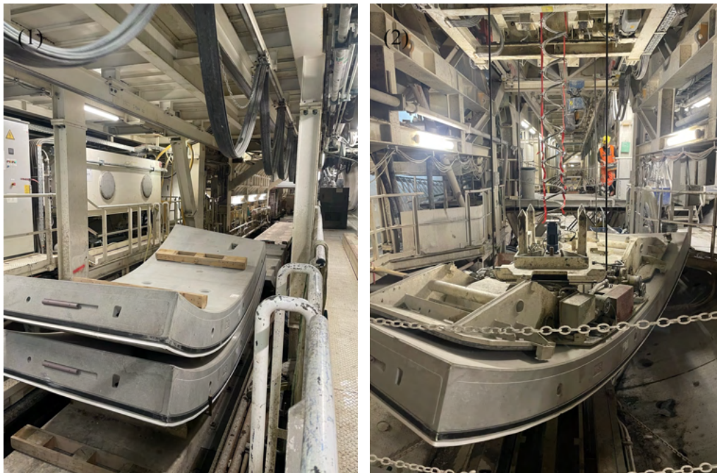
Abbildung 19: Versorgungszug im Inneren der TBM (1) und Vakuumgreifer mit Tübbing im gedrehtem Zustand (2)
