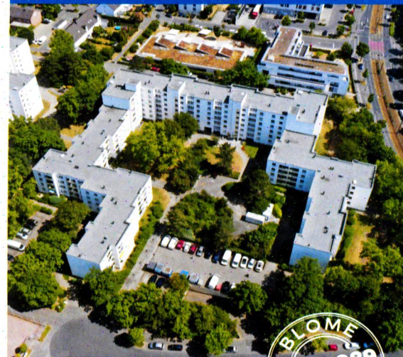
Bonn: Sanierungsprojekt mit 300 Wohneinheiten
