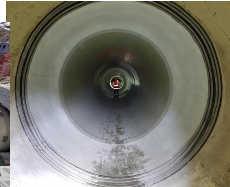
Triebwasserweg nach dem Relining
