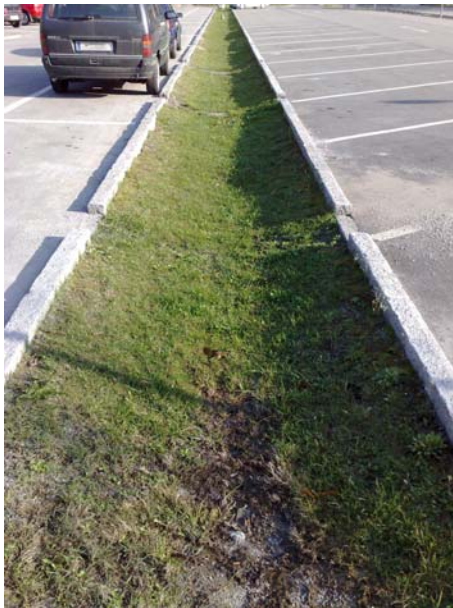
Abbildung 28: links: Mulde, rechts: vorübergehende Speicherung bei Starkregenereignissen
