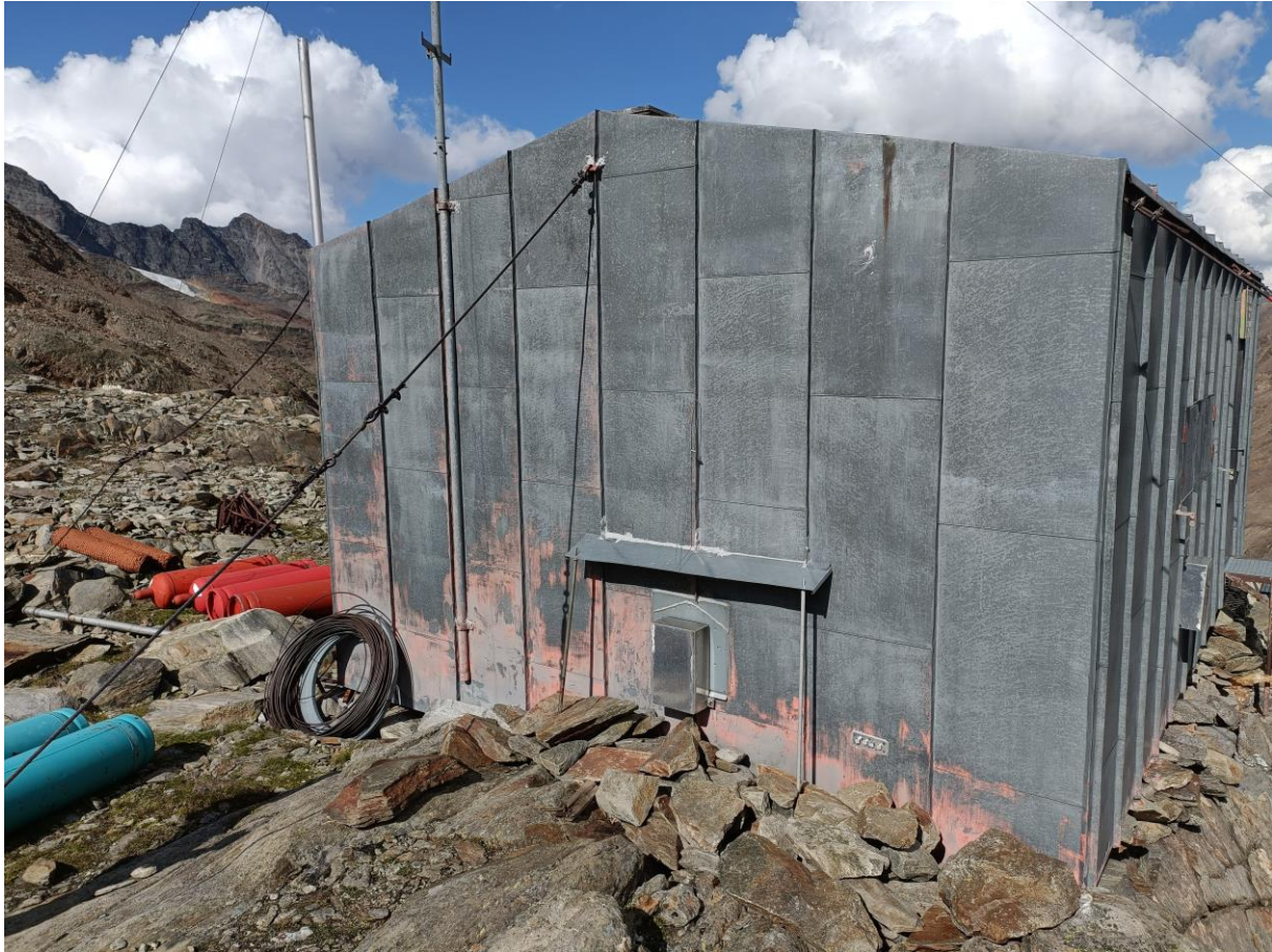
Abbildung 28: Anbau einer Abdeckung der westlichen Lufthutze. Regenwasser an der Wetterseite der Hütte sollte somit nicht mehr durch die Lufthutze in die Hütte gelangen. Foto: Rainer Prinz, 10.08.2022.
