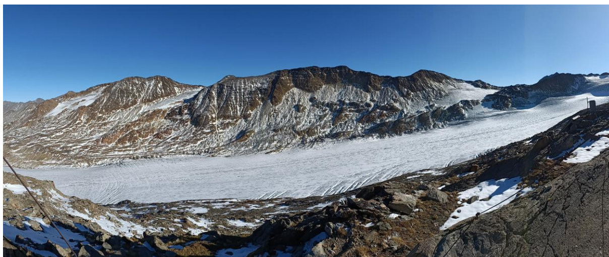
Abbildung 26: In der Flanke zum Hinteren Eis ist der Gletscher fast zur Gänze abgeschmolzen. Der tauende Permafrost macht sich durch Steinschlag bemerkbar. Foto: Rainer Prinz 22.09.2022.
