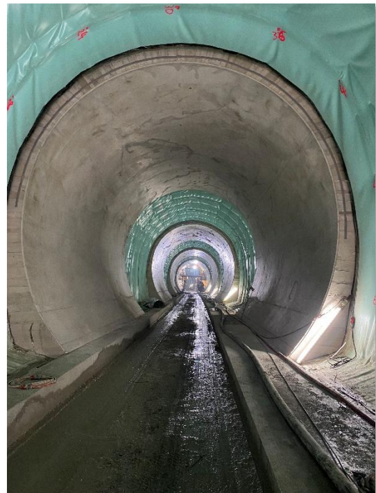
Abb. 2-8: Widerlager, KDB und Gewölbebeton [eigene Aufnahme]
