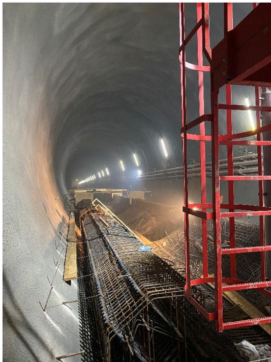
Abb. 2-7: Abdichtungsträger und Sohlgewölbe [eigene Aufnahme]
