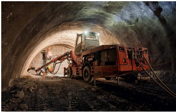
Abb. 2-5: Sprengvortrieb [77]
