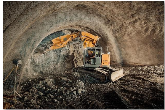
Abb. 2-6: Baggervortrieb [78]
