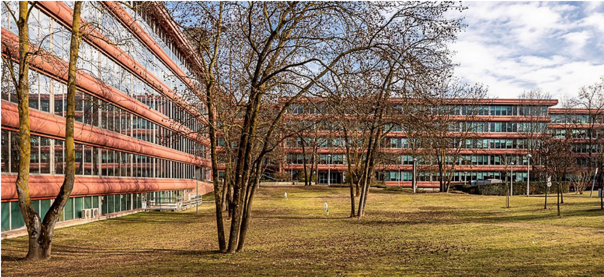
Terzo Palazzo Uffici, San Donato Milanese
