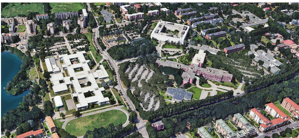
Terzo Palazzo Uffici, San Donato Milanese (Google Earth, 2024)
