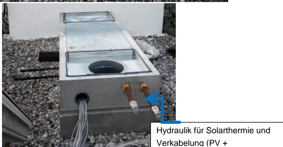
Abbildung 82 Sockelanschluss-Details I
