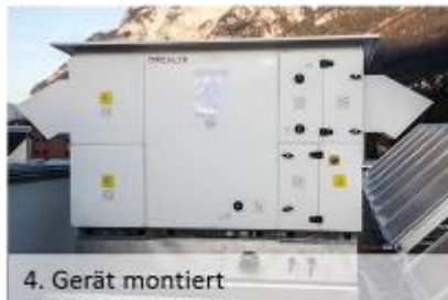
Abbildung 84 Montage des Dachgeräts
