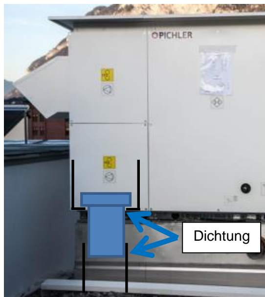
Abbildung 81 Dichtung Anschluss Dach
