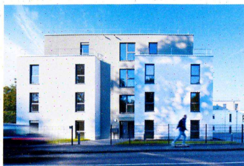
Serieller Wohnungsbau geht auch ästhetisch: zwei mehrgeschossige Punkthäuser in Stahl-Modulbauweise wurden in Königswinter realisiert.
