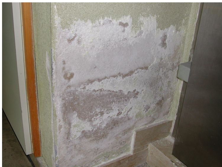
Abb. 2. Feuchtigkeitsschäden Im Erdgeschoss
