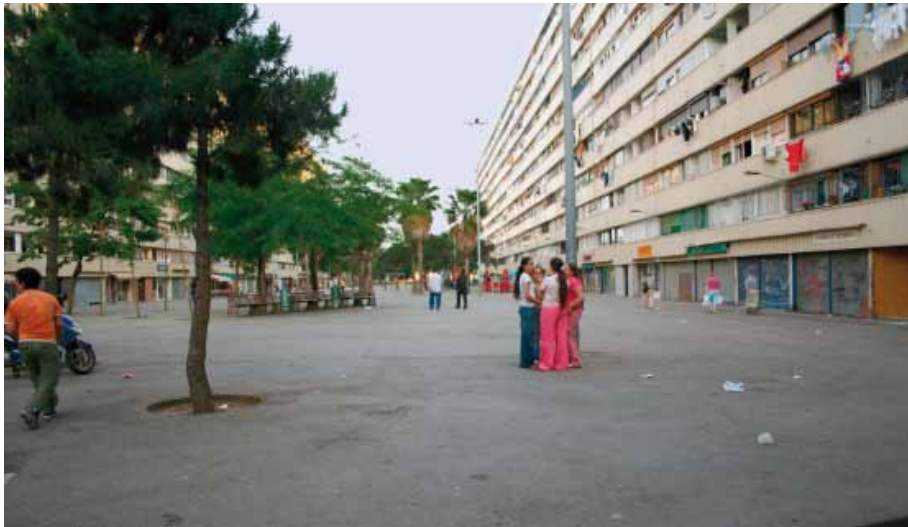
La Mina Nueva, Barcelona Spanien 2010 Bildnachweis: Ricarda Kössl
