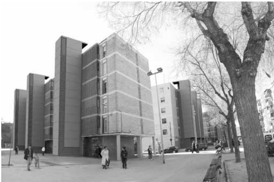
Neue Aufzüge in La Mina Vieja, Barcelona Spanien Bildnachweis: Plataforma de Vecinos de La Mina
