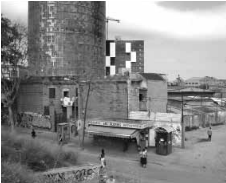
Torre Agbar-Poble Nou, Barcelona – im Spannungsverhältnis der Modernisierung Bildnachweis: Ricarda Kössl
