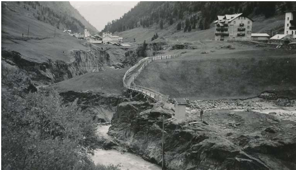
Abb. 3: Der Pegel Vent/Rofenache (vor 1936) auf dem Felssporn zwischen der Rofenache und der Spiegelache, auch Niedertalbach genannt. Pegelausstattung: Lattenpegel, Registrierpegel nach Schwimmerprinzip, begehbares Häuschen (Foto: Hydrographischer Dienst Tirol)
