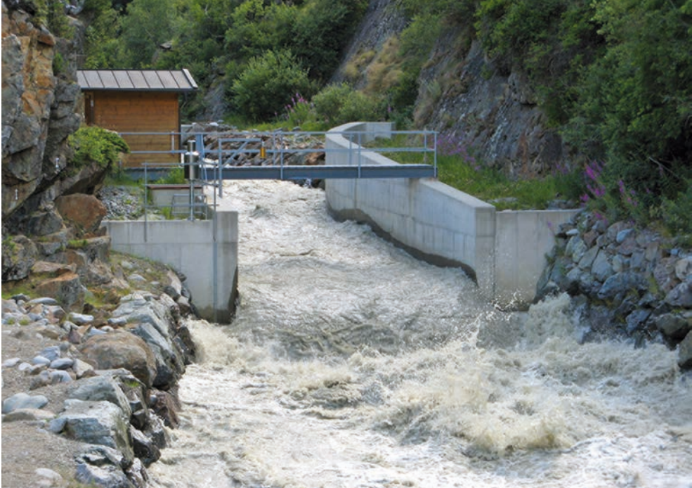
Abb. 4: Die Pegelanlage Vent/Rofenache im Jahre 2005 mit begehbarem Pegelhäuschen, Messsteg und betoniertem Gerinne mit Einlauftrumpete im Oberwasser. Gemessen werden: Wasserstand (RADAR und Drucksonde), Oberflächengeschwindigkeit des Wassers (RADAR), Wassertemperatur, Schwebstoff (Trübungssonde), Geschiebe (Geophone in der Gewässersohle). Sämtliche Parameter werden kontinuierlich gemessen, vor Ort digital aufgezeichnet und mittels GPRS fernübertragen (Foto: Hydrographischer Dienst Tirol)
