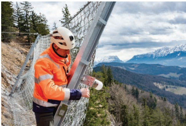
Abb. 2: Trumer Impact Monitoring Montage an einem Steinschlagschutzzaun bei Salzburg
