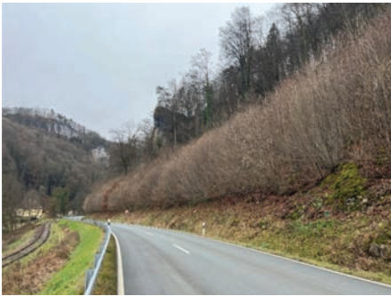
Abb. 3: Ansicht vor Freischnitt (Quelle: HTB)
