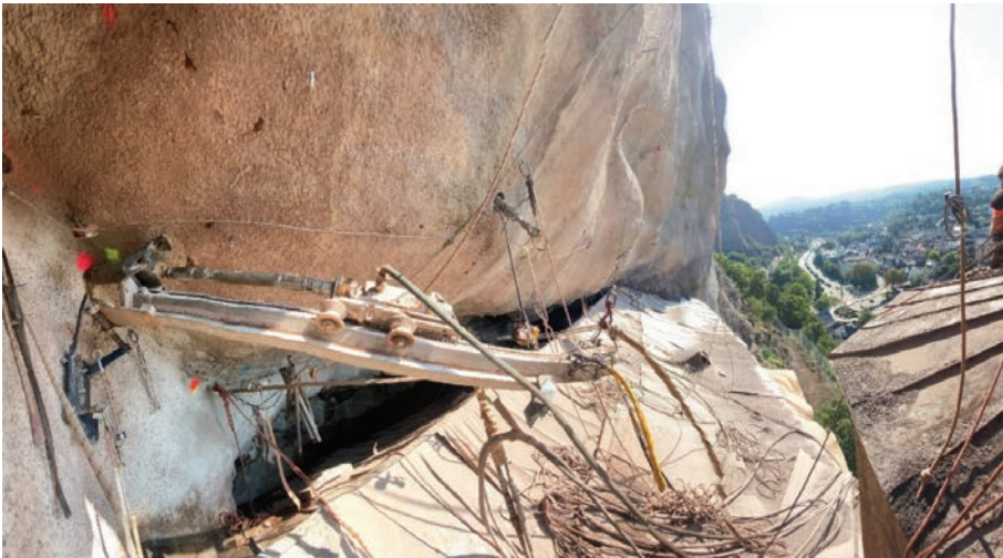
Abbildung 3, Einbau der Felsnägel im Kirchengewölbe der Felsenkirche
