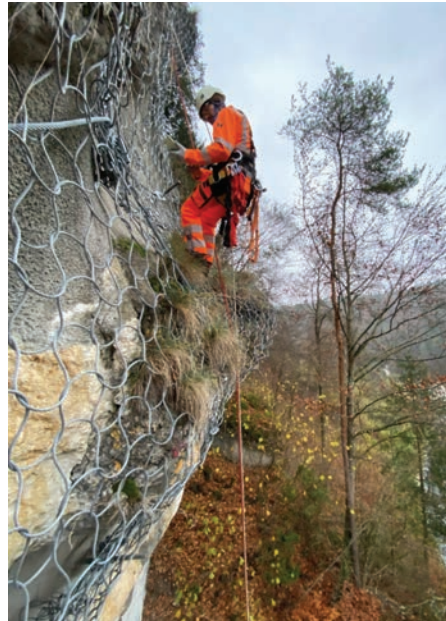
Abb. 6: Die Dokumentation von Schäden wird vor allem unter Seilzugangpositionierung über die App erleichtert.
