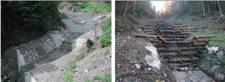
Abb. 1 und 2: Errichtete Betonquerbauwerke am Mauerbodenbach aus den Jahren 2006/2007 (aus von der Thannen et al., 2018)
