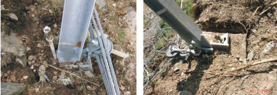
Abb. 1: Beschädigte Fundationen durch Druckkräfte
