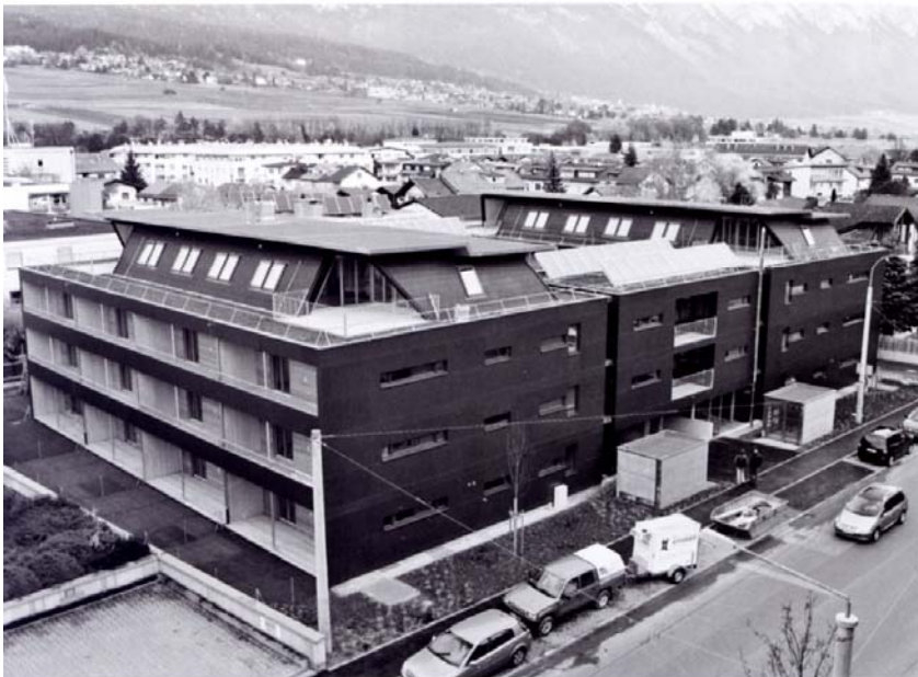
Innsbruck, Schützenstraße: Forschungsprojekt „Mehrgeschossiger Wohnbau in Holz. Erarbeitung praxisgerechter Details unter besonderer Berücksichtigung des Schallschutzes“ Architekt: Helmut Reitter Projektpartner: Holzcluster Tirol, Wohnungseigentum, Schaffner Holzbau, Energie Tirol, Land Tirol Laufzeit 2005–2006
