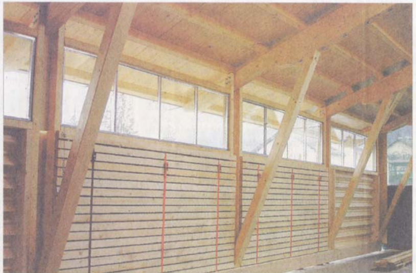
Die Holzkonstruktion ist mit zimmermannmäßigen Knoten verbunden. Die Wände können als Erdwände (linke zwei Felder) oder als Faltwerk (rechts) gebaut werden. Der Prototyp des Gebäudes ist bei der Firma Felder System Stalltechnik in Absam zu besichtigen.
