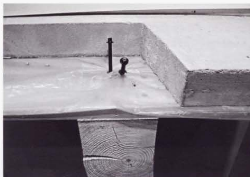
Mechanische Verbindung mit Spezialschrauben
